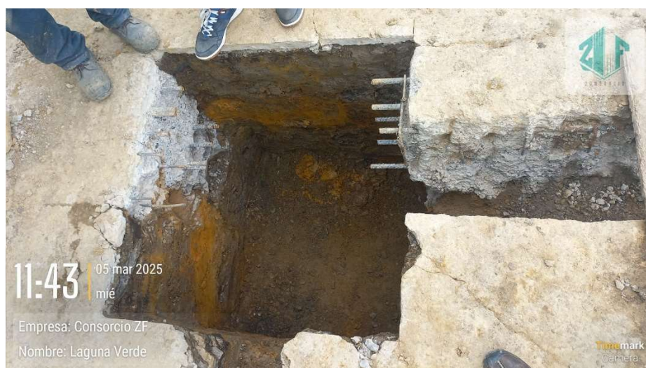
Ilustración 35. Corte de aceros.
