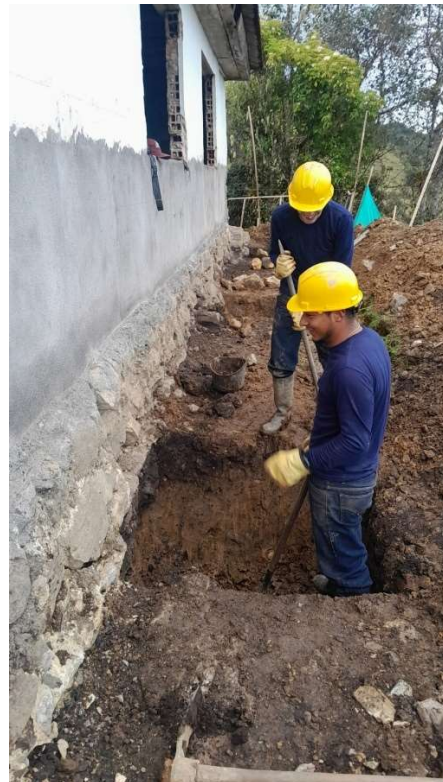
Ilustración 27. Ampliación de excavación
