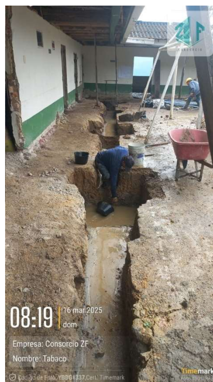
Ilustración 29. Evacuación de agua.
