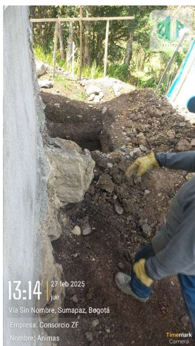
Ilustración 24. Material Rocoso en excavación
