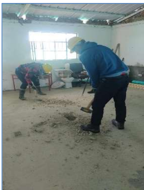
Ilustración 6. Demolición de placa
