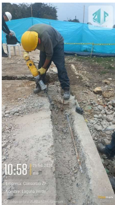
Ilustración 33. Demolición de zapatas.
