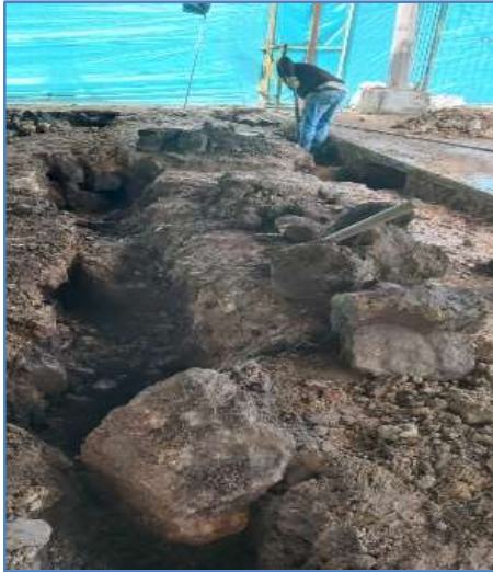
Ilustración 3. material rocoso hallado en las excavaciones
