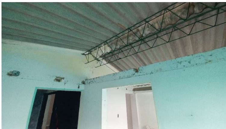
Ilustración 17. Estructura sin viga de confinamiento.
