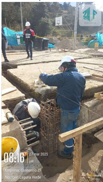
Ilustración 38. Toma de niveles en placa.
