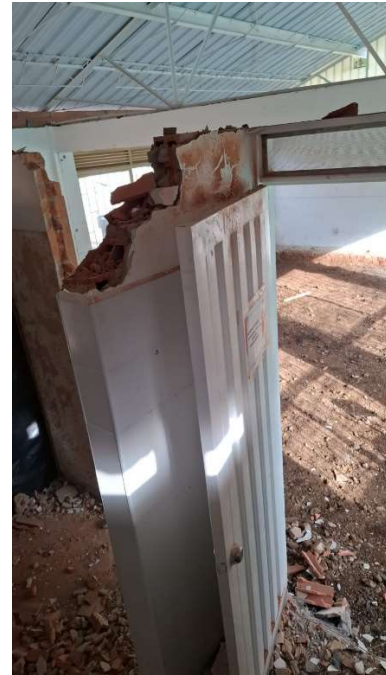
Ilustración 20. Demolición de muro despensa - cocina
