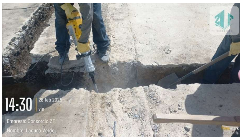
Ilustración 32. Demolición de vigas.
