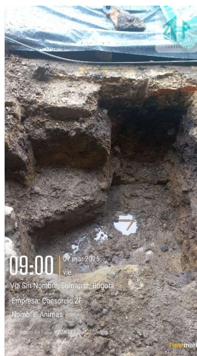
Ilustración 25. Material Rocoso en excavación.
