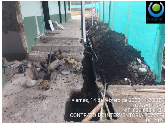
Ilustración 9. Excavación de propuesta de 0.8 X 0.8 m.
