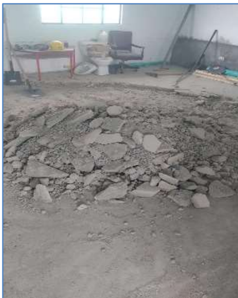
Ilustración 5. Demolición de placa.
