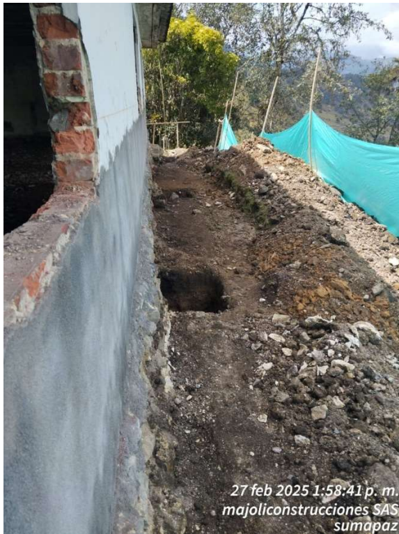
Ilustración 26. Excavación inicial.
