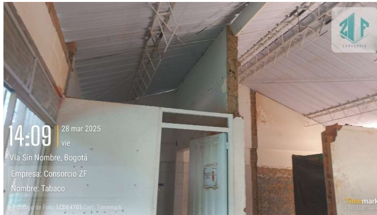
Ilustración 21. Demolición muro cocina - comedor.
