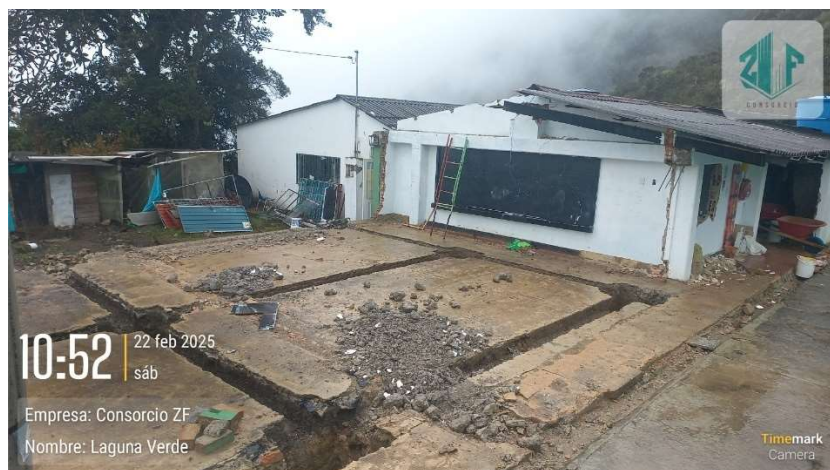
Ilustración 30. Excavación de 0.8 x 0.8 m.
