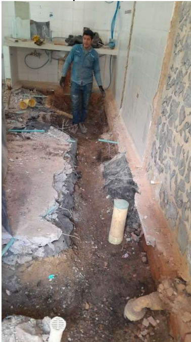
Ilustración 19. Demolición de placa en cocina.
