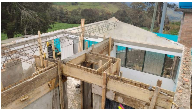
Ilustración 18. Construcción de vigas de confinamiento.
