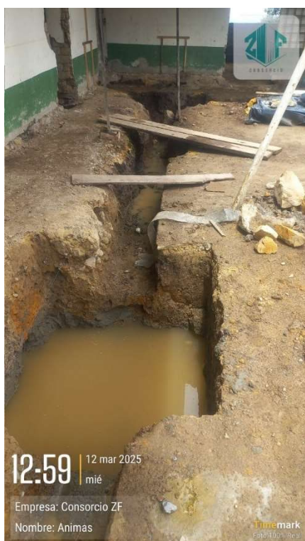
Ilustración 28. excavaciones inundadas.
