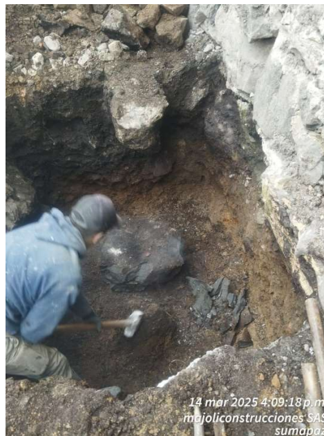
Ilustración 23. Material Rocoso encontrado en excavaciones
