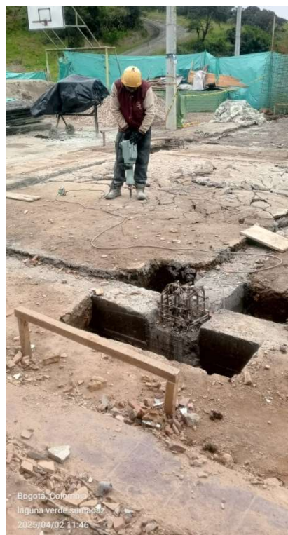
Ilustración 39. Demolición de Placa de cimentación.
