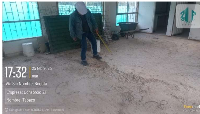
Ilustración 15. Desgaste de placa existente
