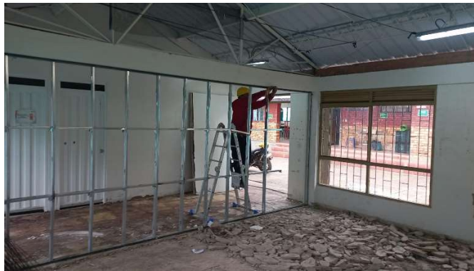
Ilustración 13. Retiro de alíado en piso.
