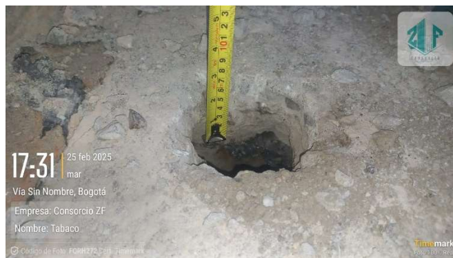
Ilustración 14. Espesor de la placa menor a 5 cm
